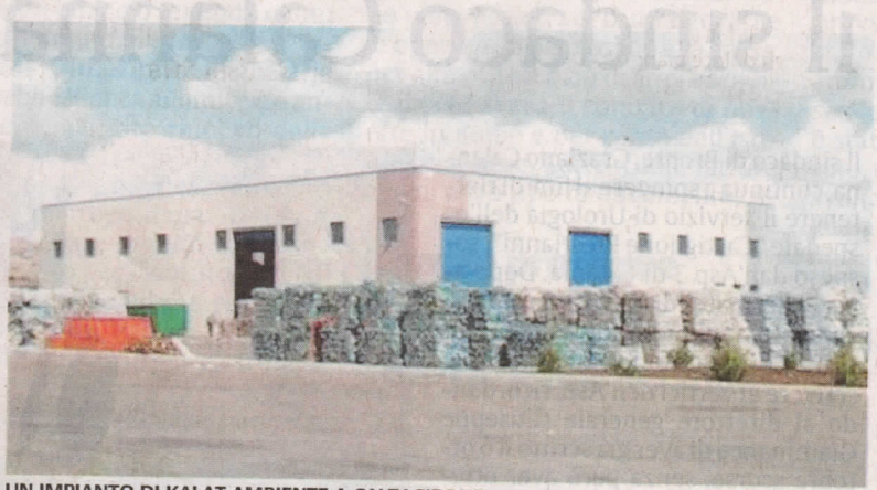
UN IMPIANTO DI KALAT AMBIENTE A CALTAGIRONE
